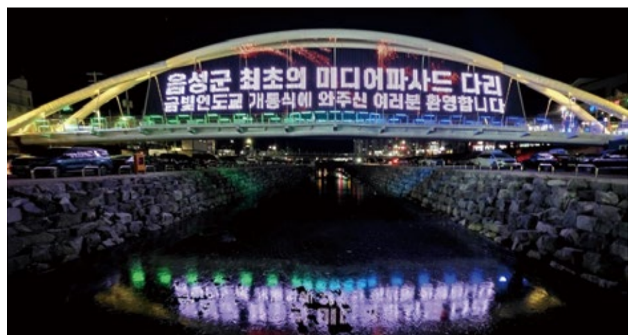
충북 음성군 농촌중심지에 조성된 '금빛인도교' 미디어파사드.
