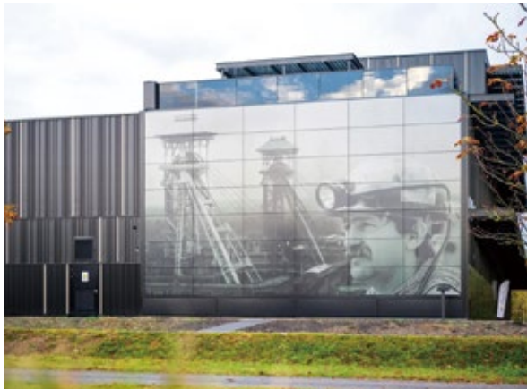
디지털프린팅이 적용된 BIPV가 설치된 건물들의 모습.
