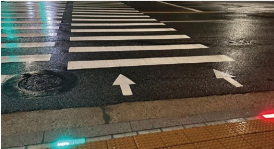
고장난 채로 방치된 바닥신호등의 모습들.
