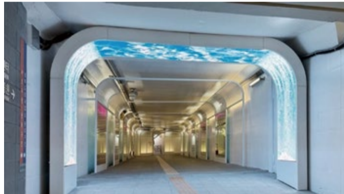
잠수교 지하보도 입구의 미디어게이트(왼쪽)와 다이크로익을 활용한 경관시설.
